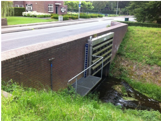
Figuur 6: De buitendijkse zijde van de duikerconstructie.
