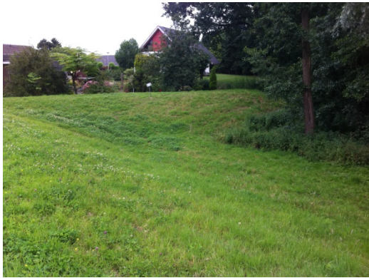
Figuur 4: Bestaande groene kering (richting hoge grond)
